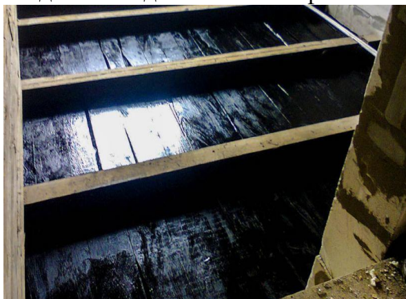
Сурет 6 а Битум лакпен боялған ағаш конструкциялар
