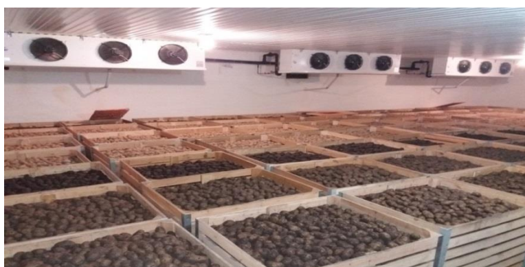
Рисунок 1. Размещение картофеля в контейнерах и воздухоохладителей в охлаждаемом помещении овощехранилища ТОО «Бирлик - 4».
