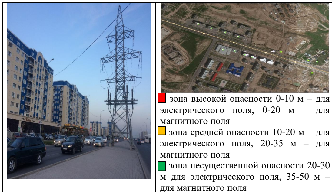
Рисунок 12 - Общий вид опоры воздушной линии – 110 кВ, установленной в микрорайоне Нұрсәт и геоинформационная карта по градиенту опасности электрического и магнитного полей.
