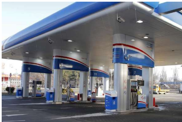
Рис. 1 Действующая авто-заправочная станция
